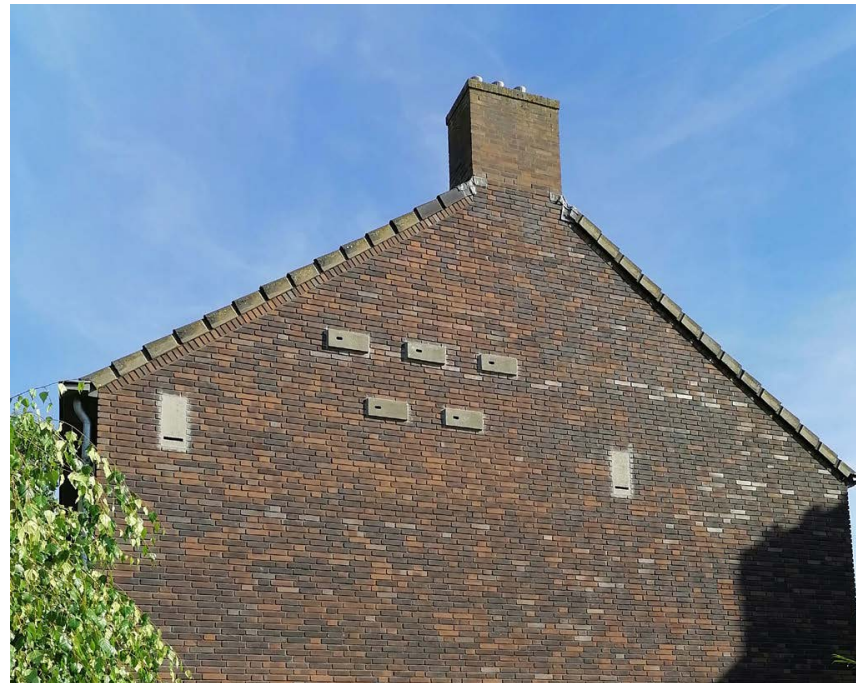
Figuur 20: Ingemetselde nestkasten voor vleermuizen en vogels
