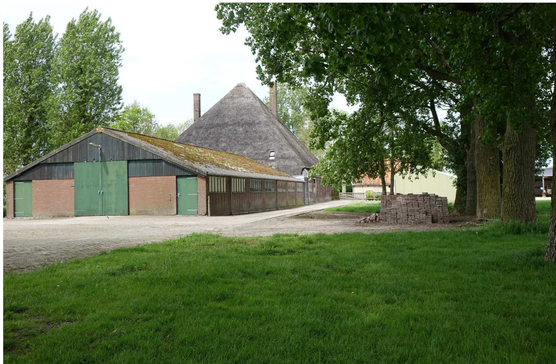
Figuur 3. Achterzijde van het erf aan de Herenweg 104 te Hoogwoud
