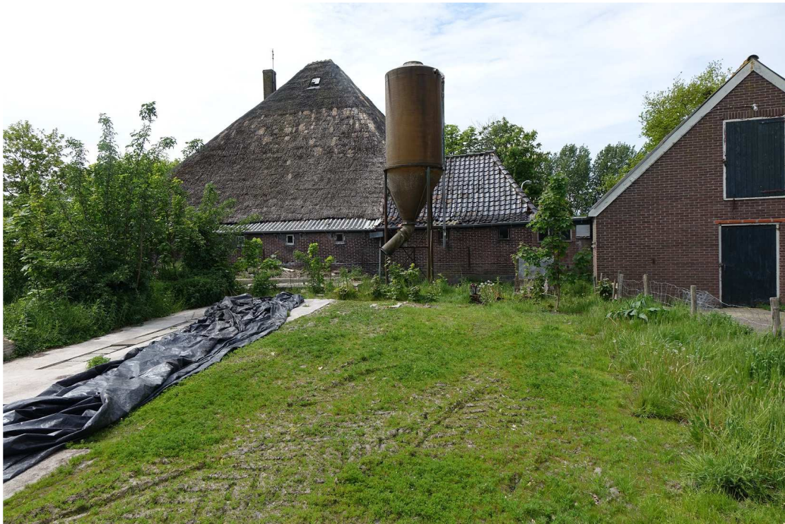
Figuur 3. Achterzijde van het erf aan de Herenweg 98 te Hoogwoud
