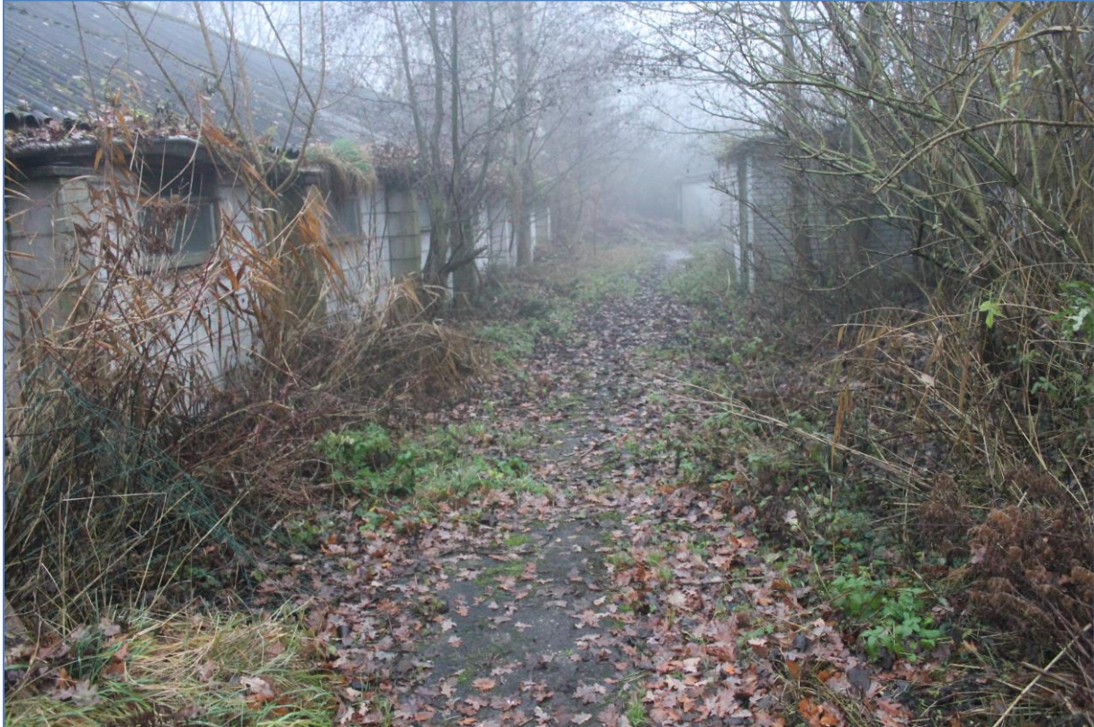
Afbeelding 2. huidige situatie met in verval geraakte opstallen
