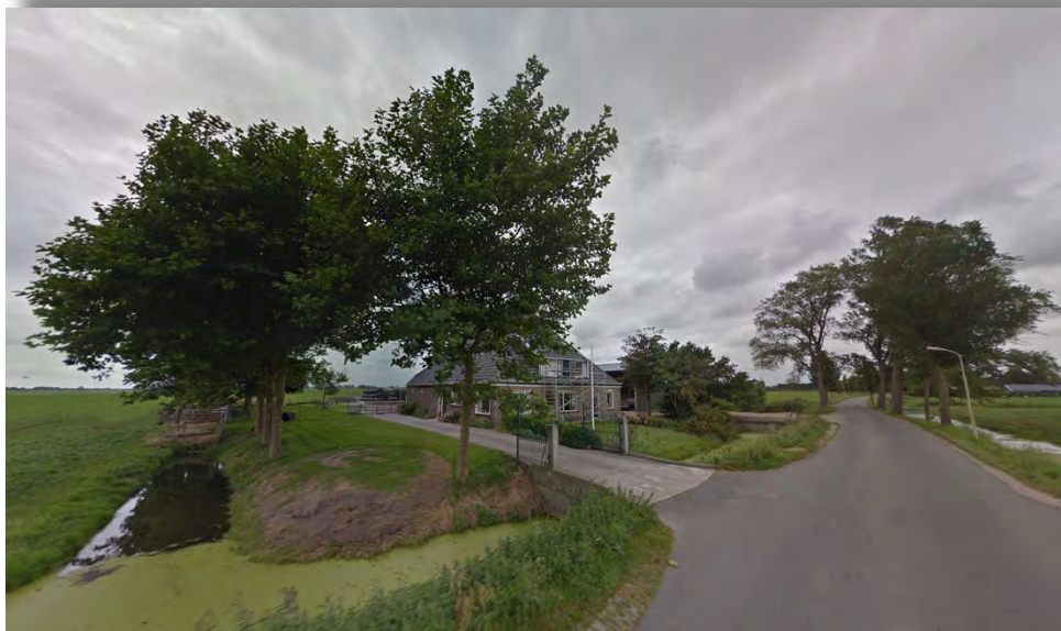
Bestaande situatie in Zomerdijk 22, Spanbroek
